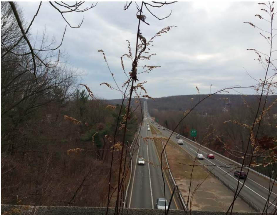
Vista desde el portal sur, mirando hacia la Salida 59
